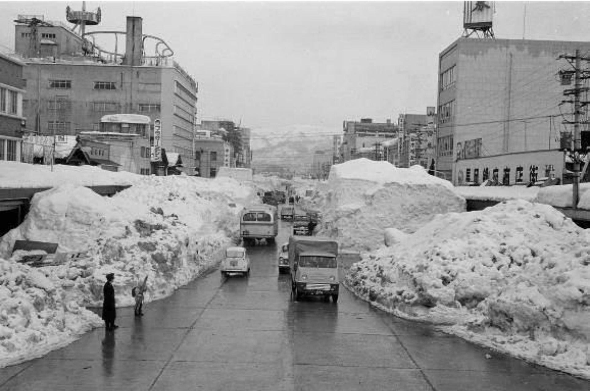
S 38年 1月豪雪（1963年）：見渡す限りの雪の中、 消雪パイプ の道路だけは黒々と路面を見せていた（長岡市大手通）
